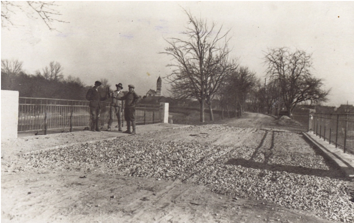
Die fertige Brücke über den Kraichbach auf dem Rheindamm Ketsch – Speyer im Jahr 1932. Baubeginn war der zweite Weihnachtsfeiertag 1931.
