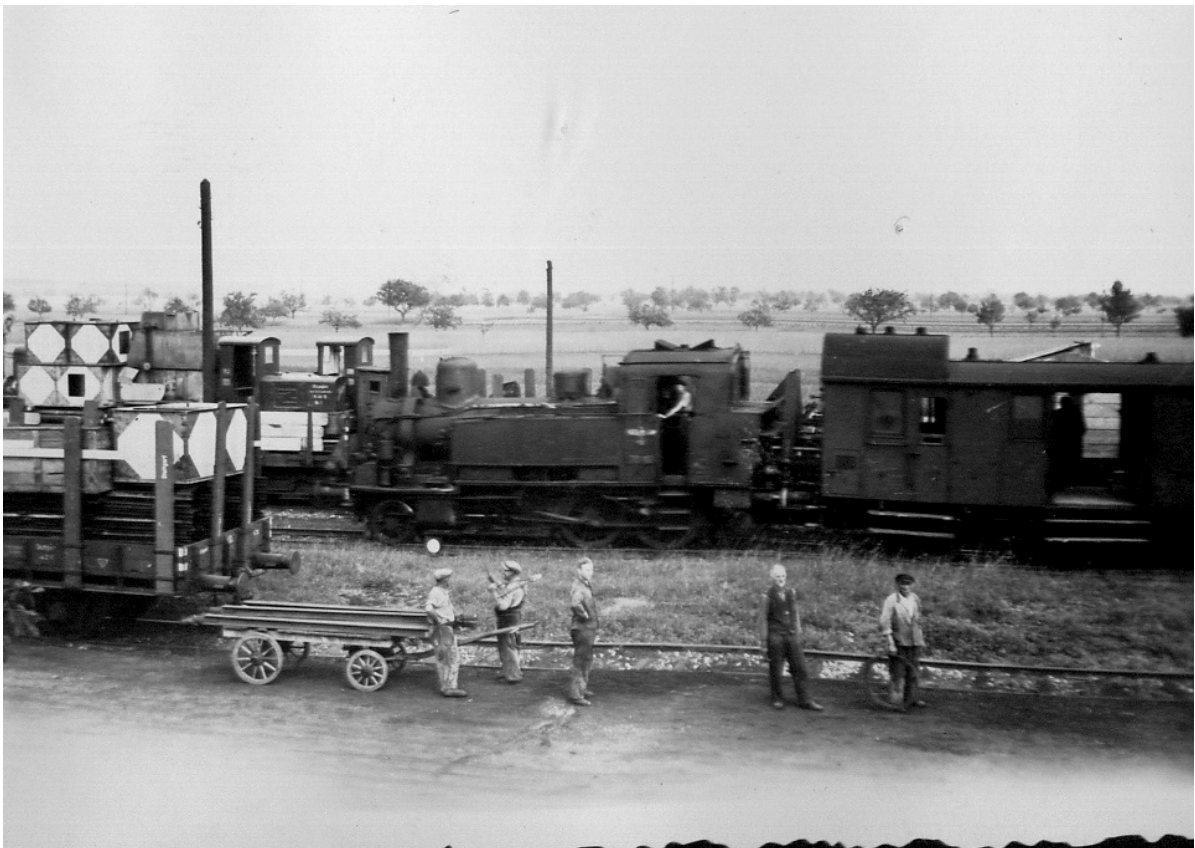
Der Transportzug mit Geräten, Baumaschinen und Material im Bahnhof Brühl.
