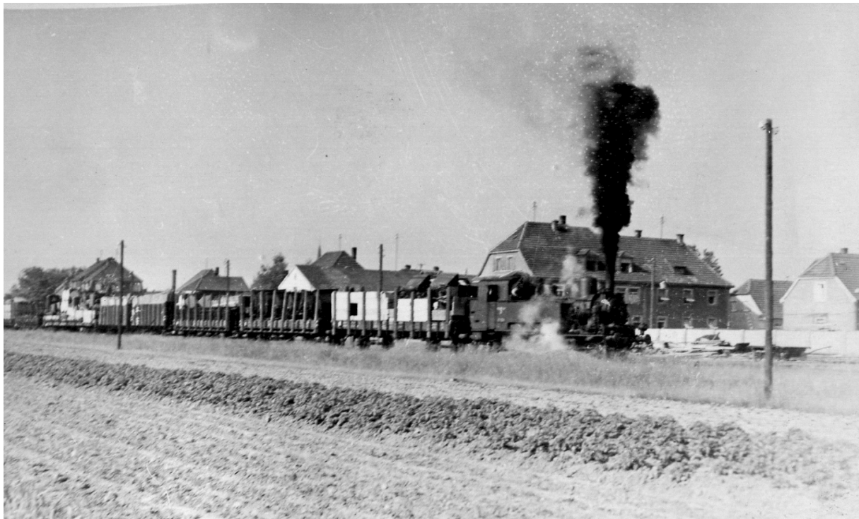
Gerätezug im April 1943 im Bahnhof Brühl. Ziel ist der Golf von Biskaya, wo die Firma A. Langlotz Bunker für den Atlantikwall baut.
