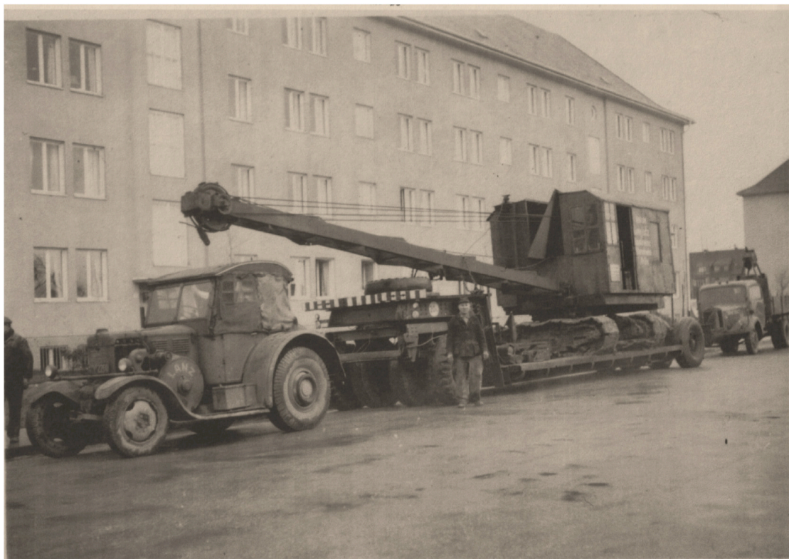
Zugmaschine, Tieflader mit Bagger und LKW der Firma Anton Langlotz.
