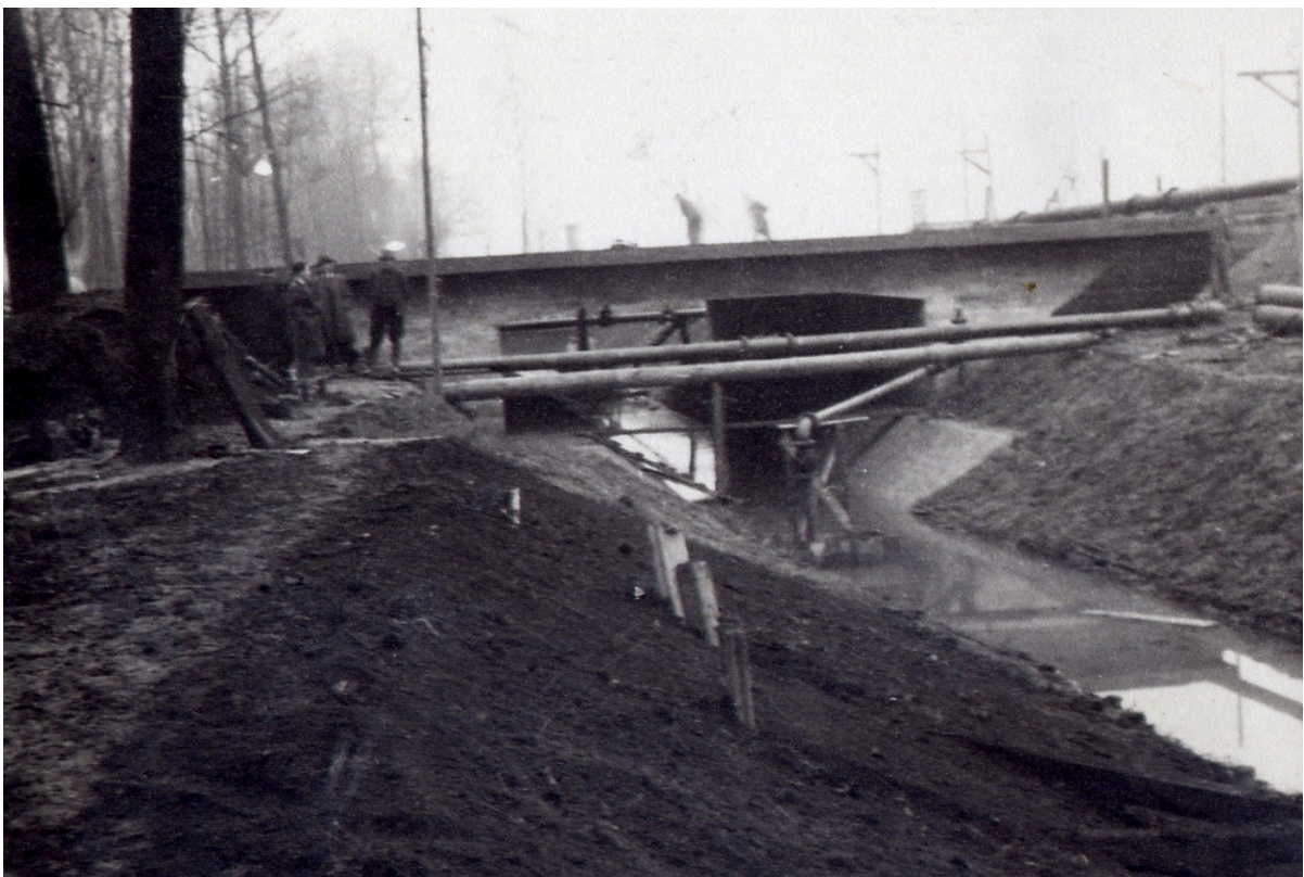
Pfinz-Saalbachbrücke bei Karlsruhe. Absturzschwellen mit teilweiser Uferbefestigung zwischen Autobahn und Graben.
