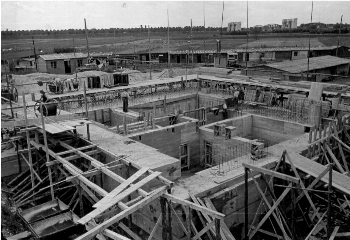
Bauarbeiten für den Bunker auf dem Aubuckel in Mannheim.
