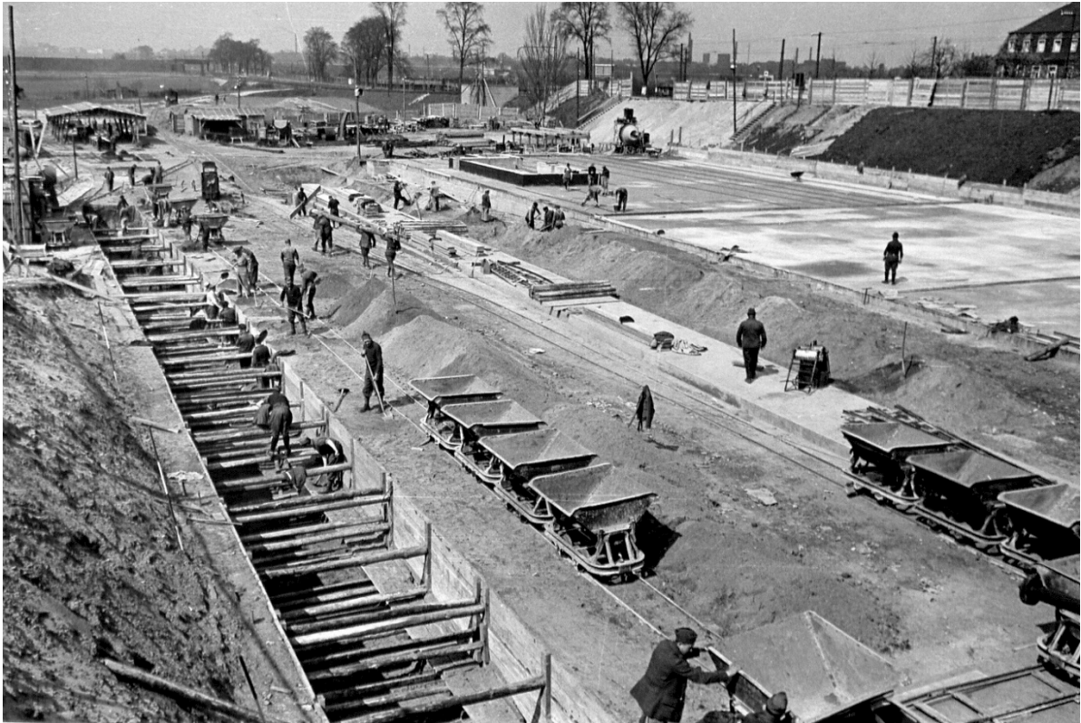
1941: Baustelle Feudenheimer Flak-Bunker.
