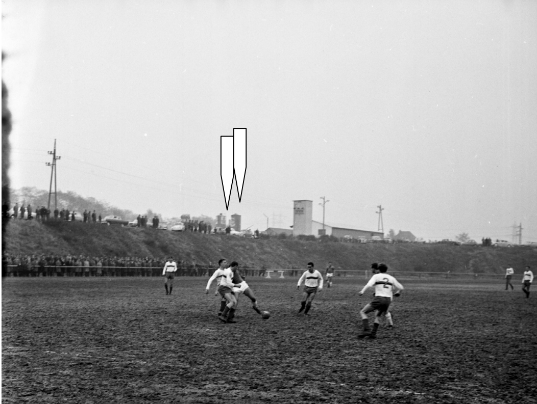
Fußballplatz des FV1918 im November 1966 bei einem Fußballspiel gegen Ketsch. Die Gebäude in der Bildmitte [Pfeile] sind Teile der Asphaltmischanlage der Firma Langlotz.
