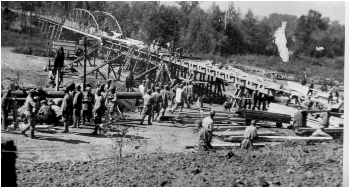
Notbrücke im Kaukasus unterm Elbrus bei Tuabs, errichtet von der O.T.-Einheit Fa. A. Langlotz
