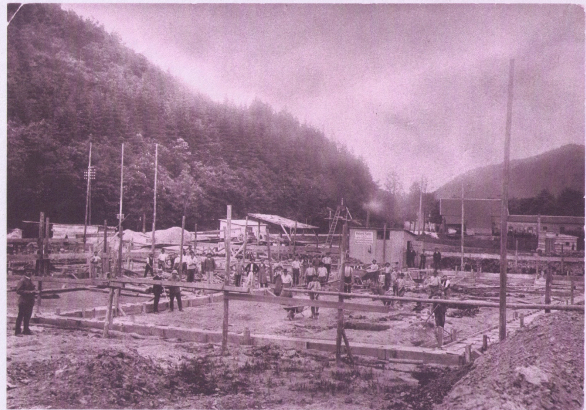
Erster Großauftrag: Fundieren des Großkraftwerks Pirmasens-Biebermühl 1908.
