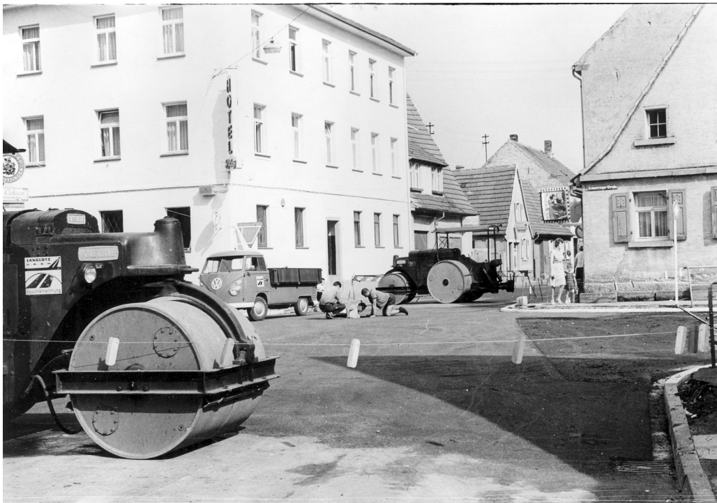
Asphaltierungsarbeiten im September 1964 an der Kreuzung Schwetzingen- / Mannheimer- / Ketscher Straße mit den Straßenwalzen der Firma Langlotz (siehe Logo an der Maschine vorne links). Das große Gebäude links ist das Gasthaus und Hotel „Zum Pflug“.
