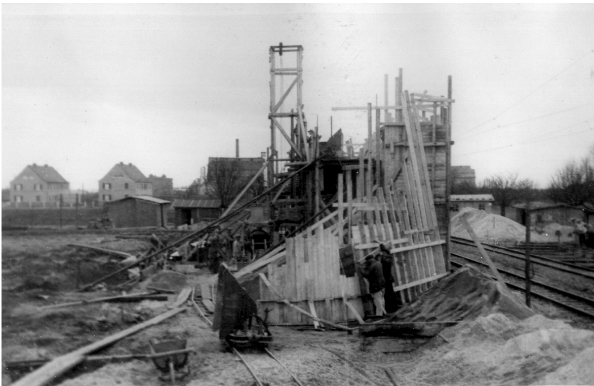
Bau einer Überführung der O.E.G-Trasse bei Heidelberg.
