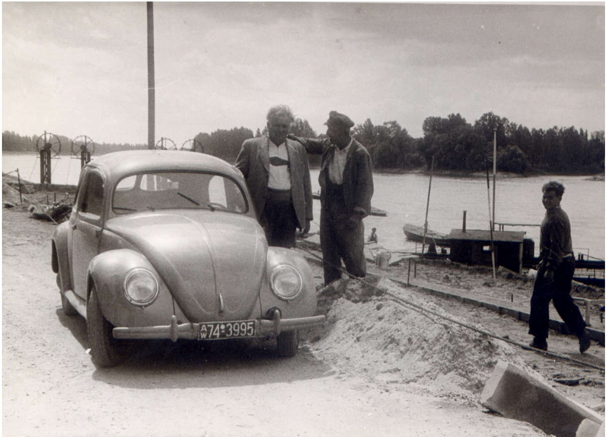
Herstellung einer Zufahrtsstraße zur „Ami-Kollerfähre“ [i.e. heute: NATO-Rampe] im Jahr 1954. Bauleiter Peter Steinbecher aus Ziegelhausen links neben dem Auto.
