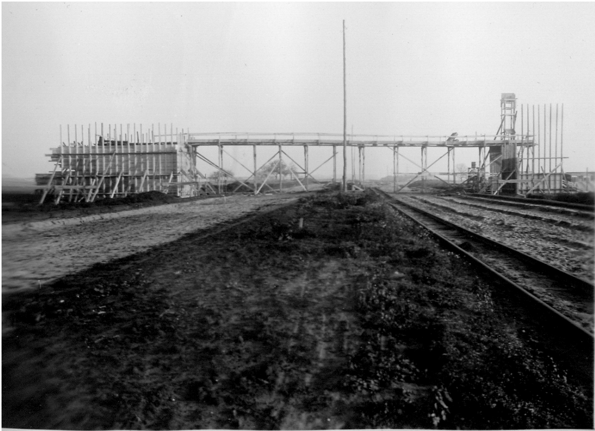
Eine andere Autobahnbrücke, die ab November 1933 im Bau ist.
