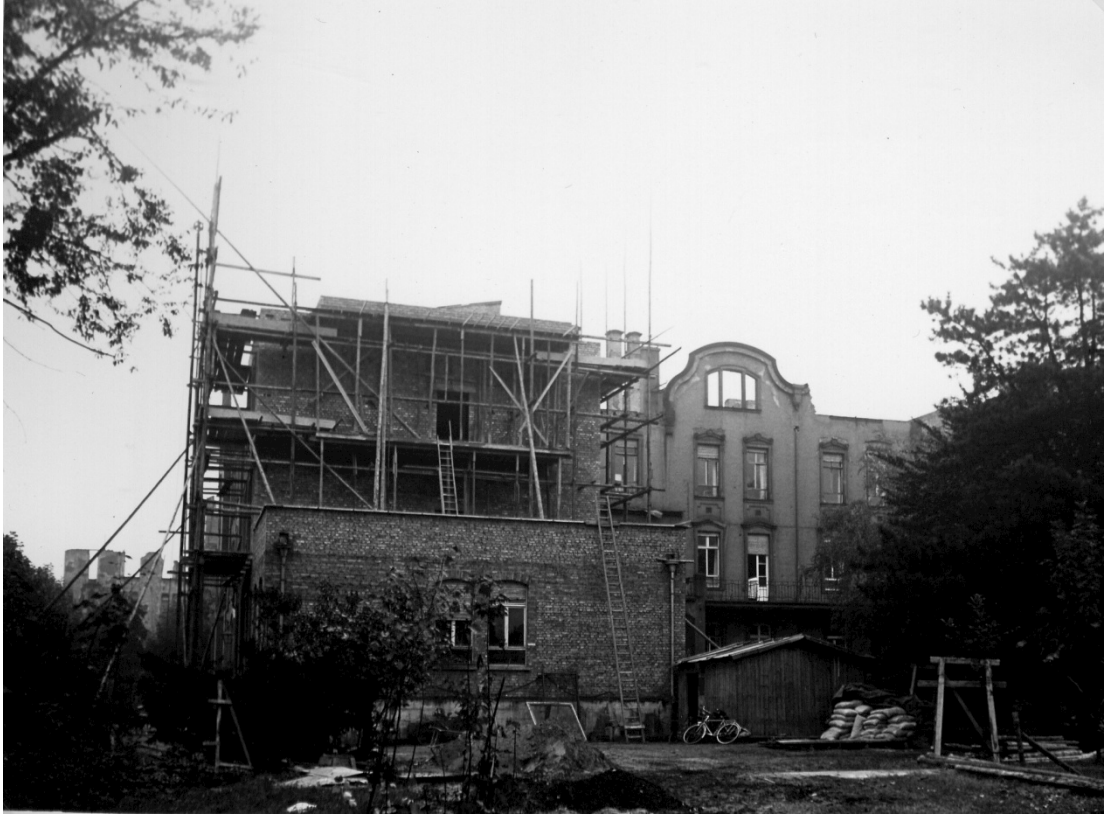
Lanz-Krankenhaus während der Arbeiten zum Wiederaufbau im November 1951.
