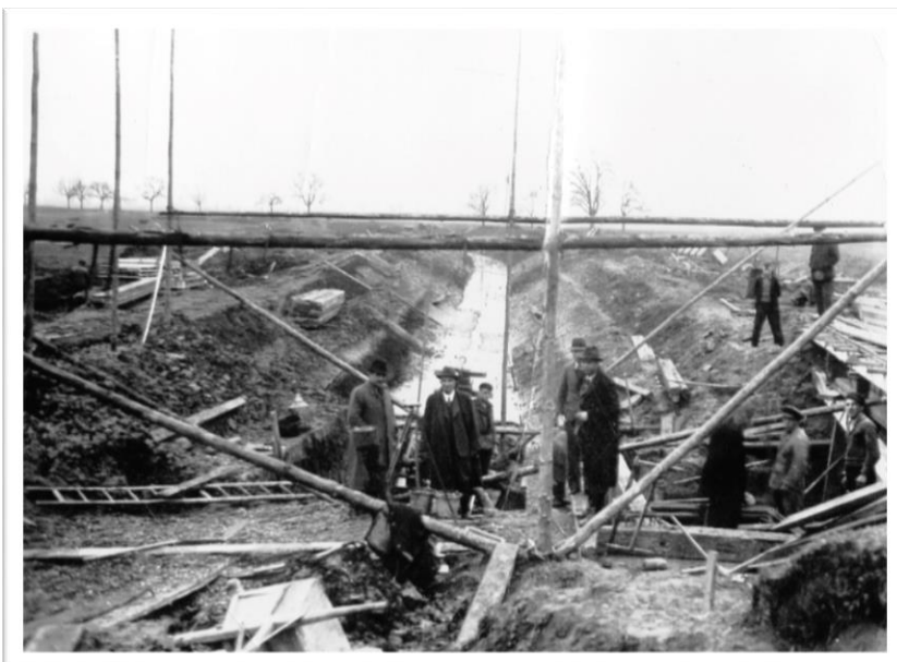
Fundament des Turbinenhauses (Bilder 9a bis 9c)
